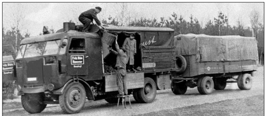
Sachsenberg-Dampfplastwagen auf Basis eines ausrangierten Foden-Lkw 1941<sup>1</sup>
