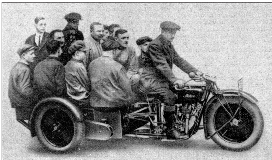
Praktischer Belastungsversuch des Mabeco-Last durch Werksangehörige 1
