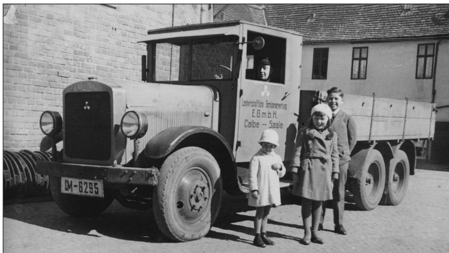
Ley 3-Achser 1928, 2,5 t, 60-PS-Sechszylinder
