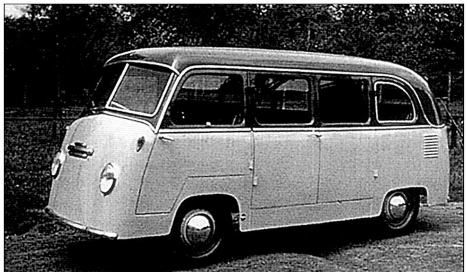
Nach dem Krieg entstanden vier Busse aus VW-Kübelwagenteilen bei Fleischer
