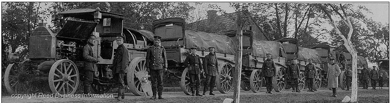
Daimler-Siemens-Train mit benzin-elektrischem Zugwagen 1908 bei den Verkehrstruppen
