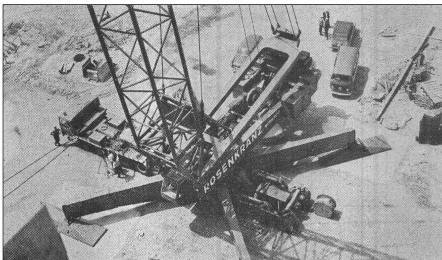
Bohne K 6001 Gittermast-Autokran, 600 t Tragkraft, 162 m Höhe
