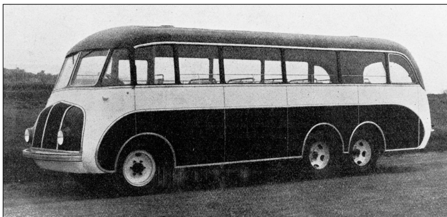
A.W.S.-Omnibus auf modifiziertem GMC-Fahrgestell 1
